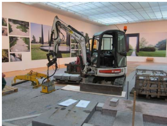
"Det tunge skyts" blev taget i brug ved etablering af belægningsmosaikken til udstillingen "SOM DET BLÅ"
